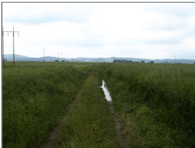
Fot. 27. Droga nr 6 proponowana do przebudowy.
