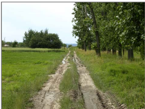
Fot. 24. Droga nr 3 proponowana do przebudowy.
