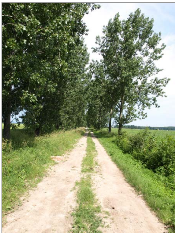
Fot. 22. Droga nr 1 proponowana do przebudowy.
