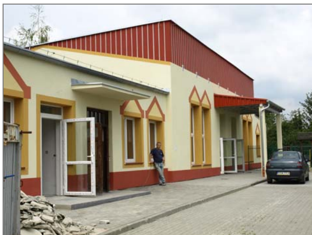
Fot. 13. Remont świetlicy wiejskiej.
