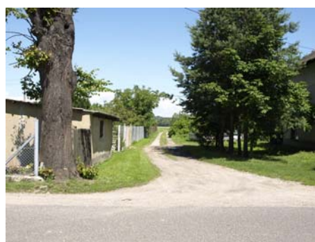
Fot. 19. Droga nr 9 na skrzyżowaniu z drogą powiatową
