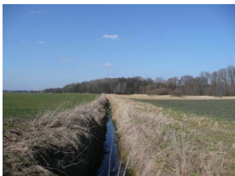
Fot. 5. Rów R-A w północnej części obrębu
