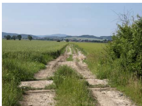
Fot. 16. Droga nr 3 na skrzyżowaniu z terenem kolejowym
