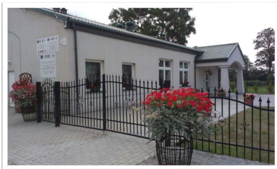
Fot. 13: Świetlica wiejska.
