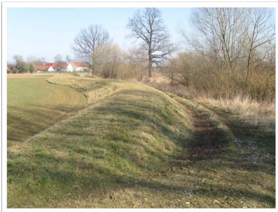
Fot. 5: Wał przeciwpowodziowy po północnej stronie rzeki Strzegomka.
