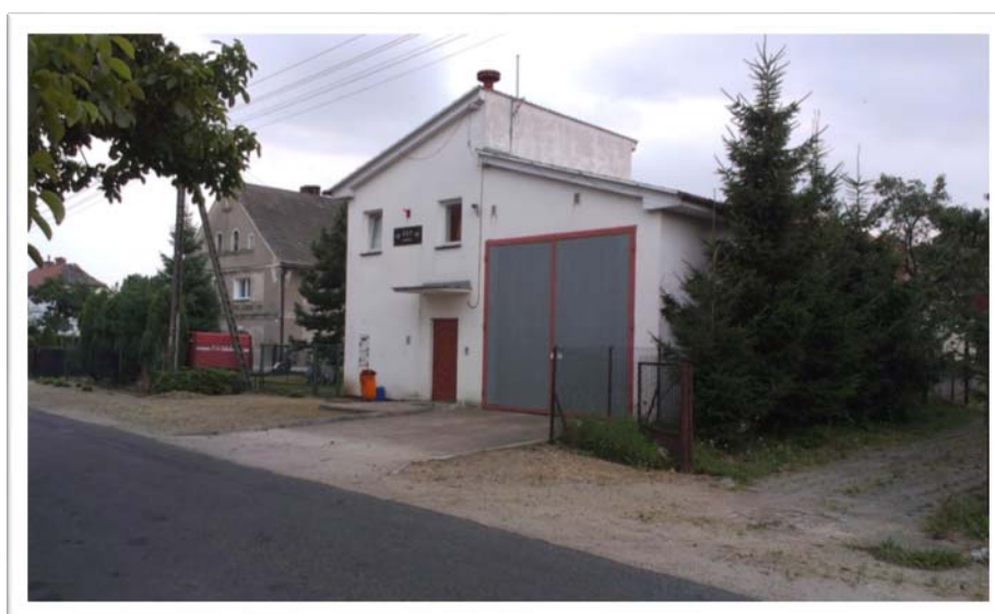
Fot. 10: Budynek OSP w Granicy.
