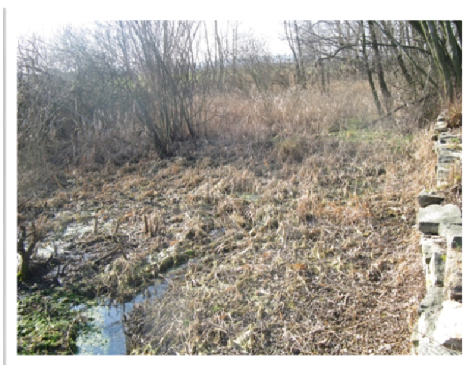
Fot. 20: Zbiornik wymagający odbudowy.
