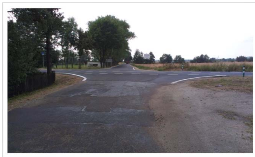
Fot. 22: Skrzyżowanie drogi krajowej nr 5 z drogą powiatową do Tomkowic.
